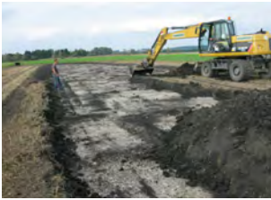
Fläche 8 Herstellung der Rohbodenstreifen in der Mitte
