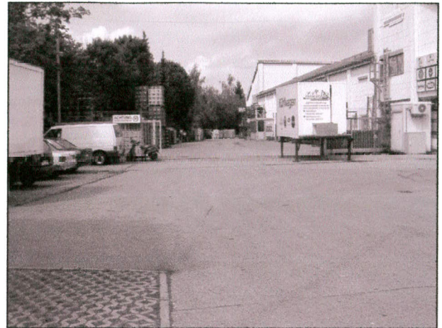
Foto 2: Stark befahrene Lagerflächen (hier Getränkelager) sind vollständig versiegelt, bei den randlichen Stellplätzen wurden aber bereits durchlässige Beläge verwendet
