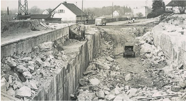
Abtragung der Fundamente der alten Unterführung, 1970.
