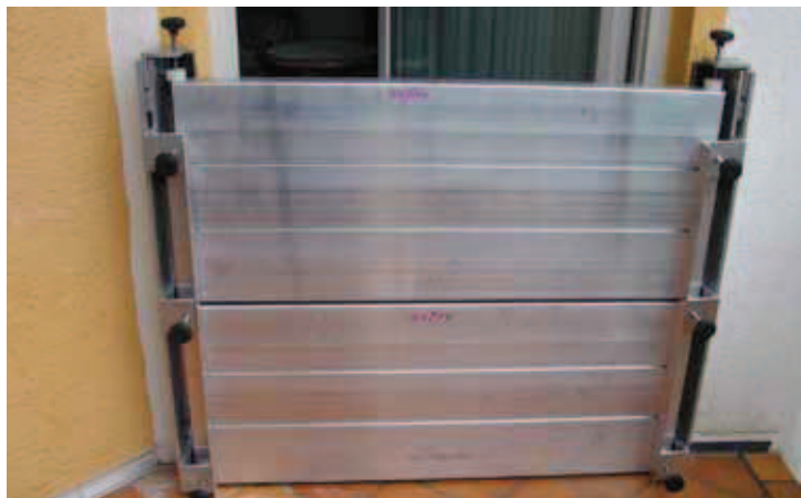
Objektschutz an Gebäudeöffnungen
