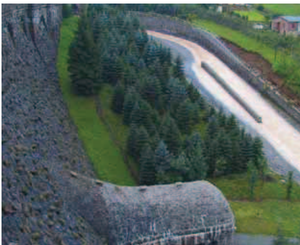
Talsperre mit Hochwasserentlastung
