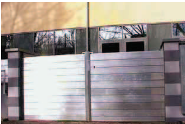
Hochwasserschutztor mit Dammbalken
