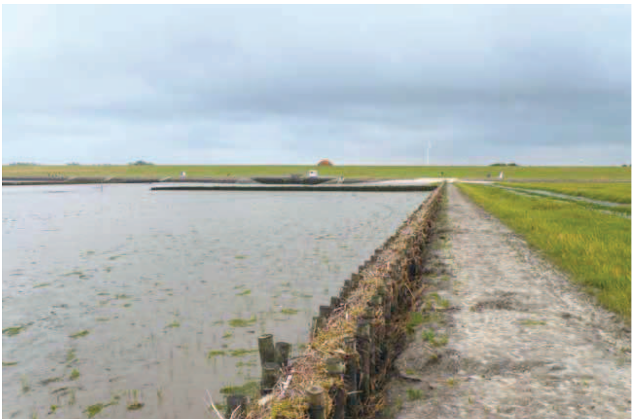
Küstenschutz mit Lahnungen und Hochwasserschutzdeich
