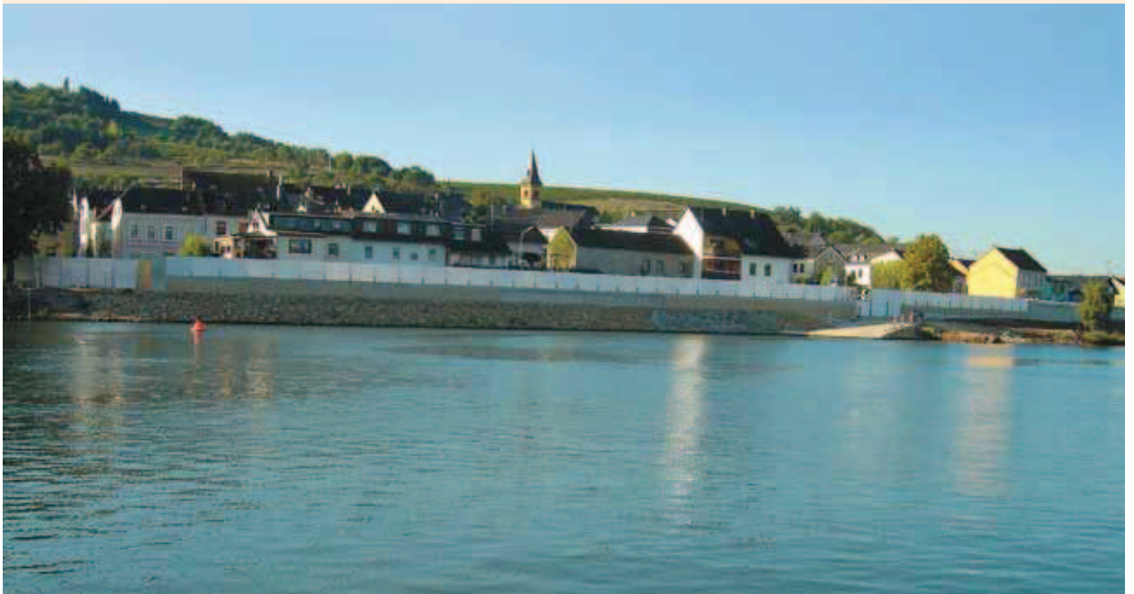
Hochwasserschutz in Oberbillig an der Mosel
