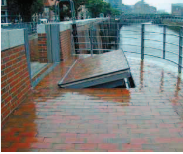
Integrierte Hochwasserschutzklappe
