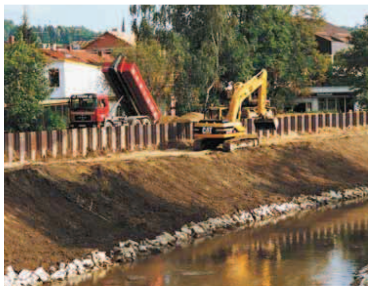
Hochwasserschutzwand mit Stahlspundwand im Bau
