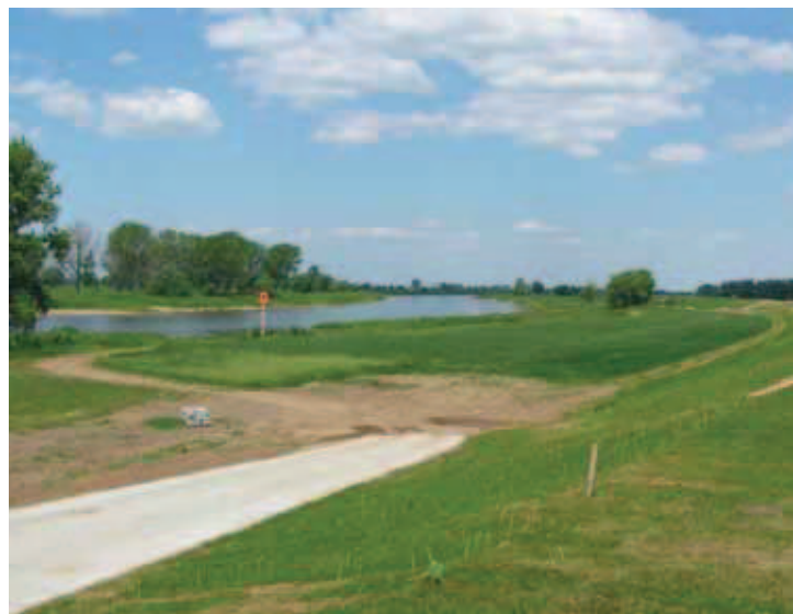
Hochwasserschutzdeich an der Elbe
