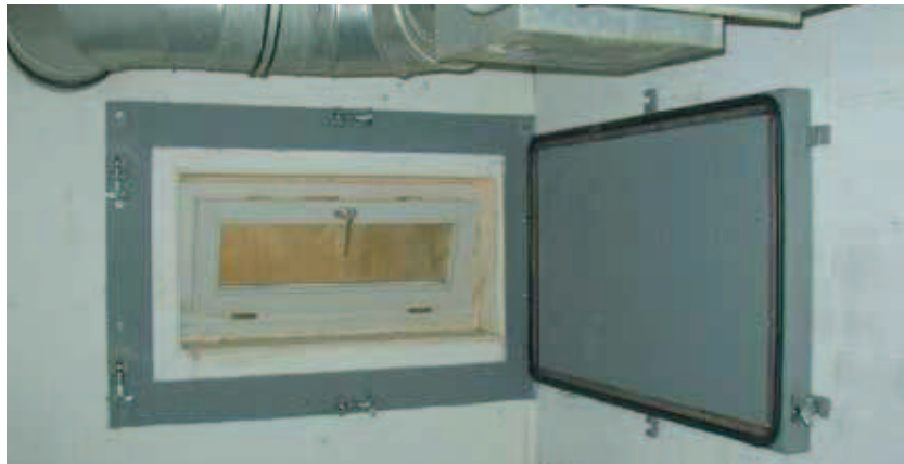
Druckdichter Fensterverschluss
