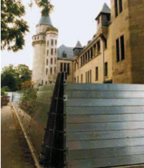
Mobiler Hochwasserschutz mit Dambalken
