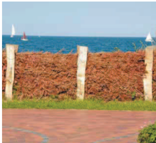
Küstenschutz mit Flechtwerkzaun
