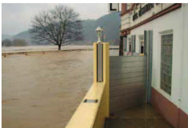
Umlaufender Hochwasserschutz mit teilmobilen Schutzelementen
