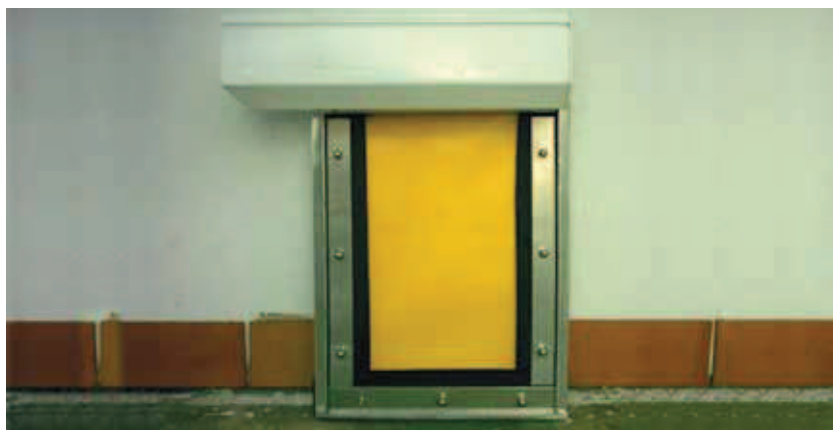
Folienabdichtung für Gebäudeöffnungen
