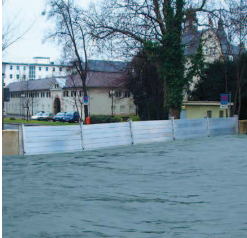
Mobiler Hochwasserschutz mit Dambalken
