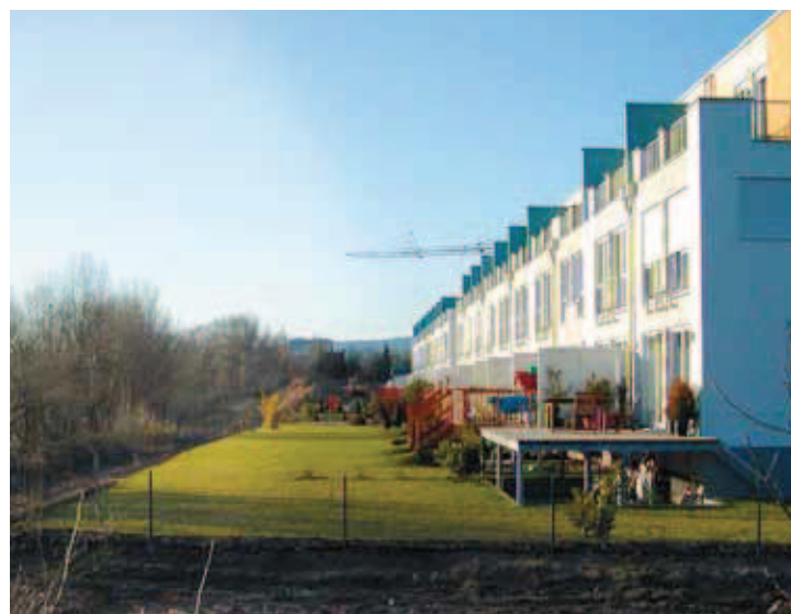
Hochwasser angepasste Bauweise mit erhöhtem Erdgeschoss
